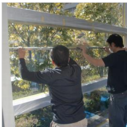
スポンジバー工法
